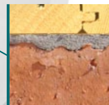
GIUNZIONE MURI PERIMETRALI / TETTO Il nastro autoespandente in PUR impregnato riempie i vuoti lasciati da eventuali irregolarità.
